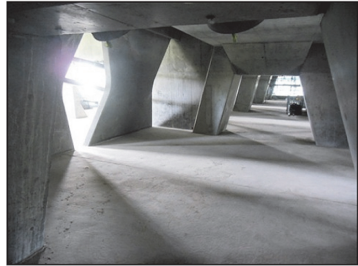
写真 - 5 桁内状況
