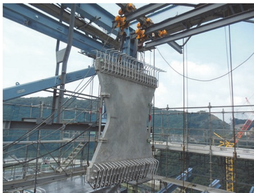
写真 - 4 バタフライウェブ架設状況
