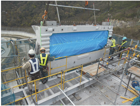
写真 - 3 プレキャストセグメント架設状況
