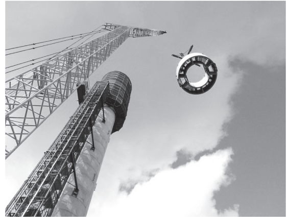
写真-2 橋脚プレキャスト部材建込み状況
