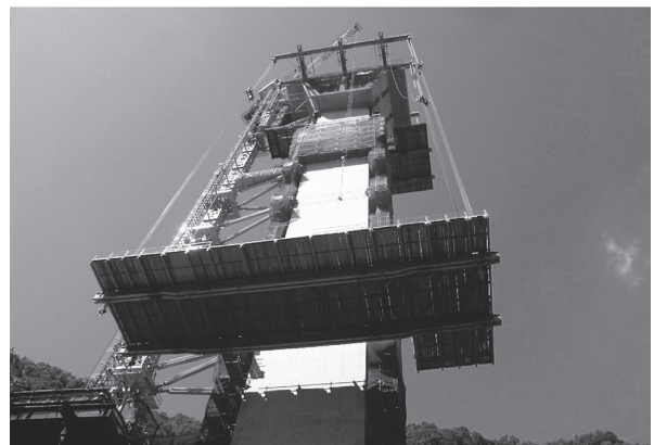
写真-5 下段作業台の一括架設
