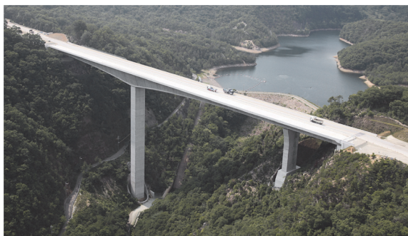
写真 - 1 完成写真
