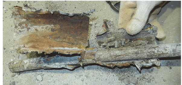
写真 - 4 グラウト充填状況確認写真
