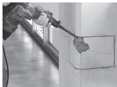
(a) はつり状況写真
