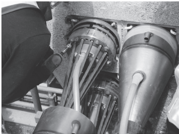
写真 - 10 C型接続具接続状況
