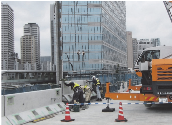
写真 - 12 EMC 壁高欄設置状況
