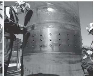
写真 - 5 機械式継手
