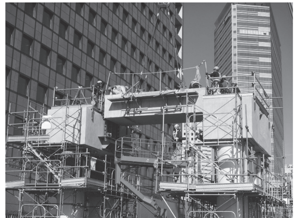
写真 - 6 ピアキャップ施工状況
