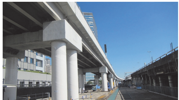
写真 - 13(c) う回路完成状況(東品川栈橋部)
