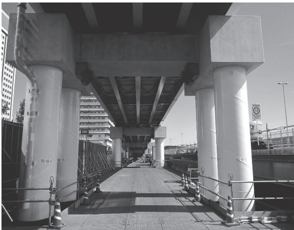
写真 - 2 う回路直下動線確保状況
