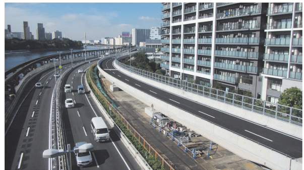
写真 - 13(a) う回路完成状況(鮫洲埋立部)
