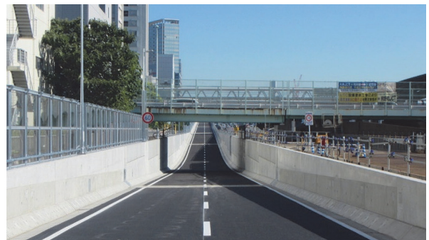
写真 - 13(b) う回路完成状況(大井北埠頭橋交差部)
