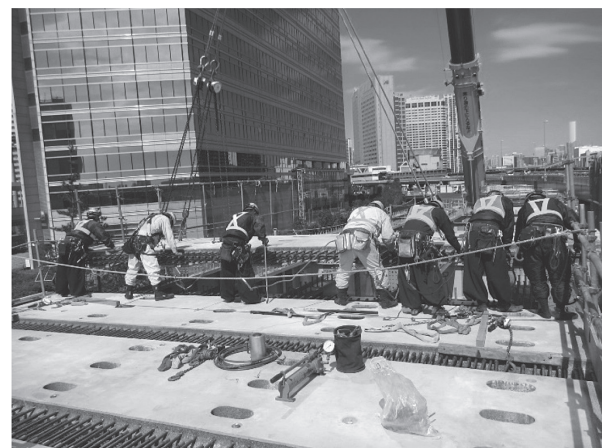
写真 - 7 プレキャスト RC 床版設置状況
