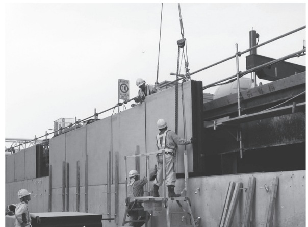
写真 - 11 プレキャストパネル設置状況
