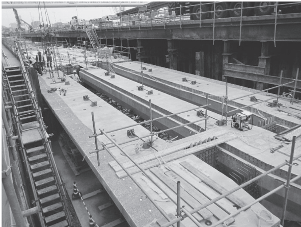
写真 - 9 プレキャスト梁設置状況
