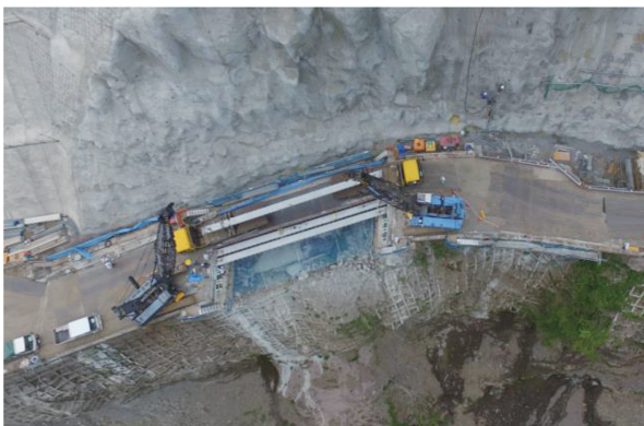
写真 - 13 主桁の架設（2期施工）
