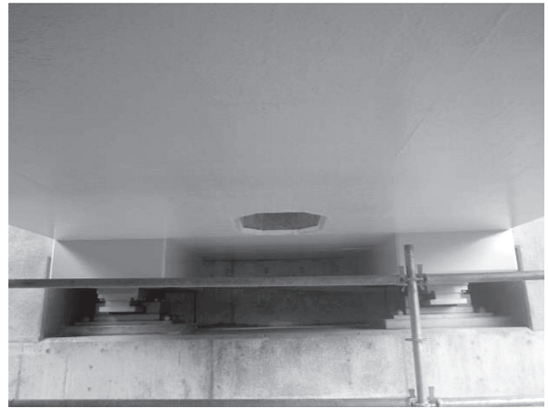
写真 - 9 支承取替え完了
