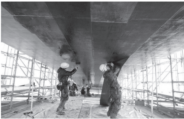
写真 - 7 炭素繊維シートの貼付け状況
