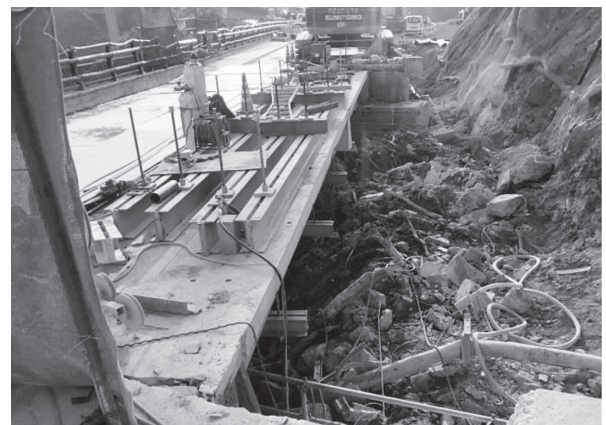
写真 - 11 既設桁の補強 (1 期施工)
