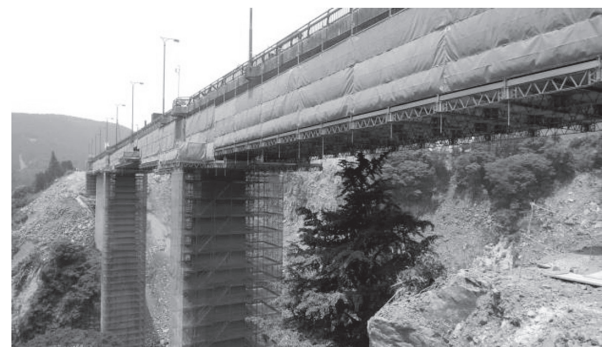
写真 - 6 トラス式吊足場
