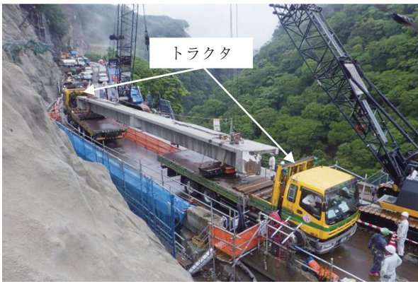
写真 - 12 既設桁撤去状況（2期施工）
