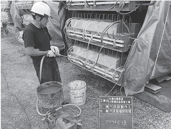
写真 - 2 空隙充填用グラウト材充填状況
