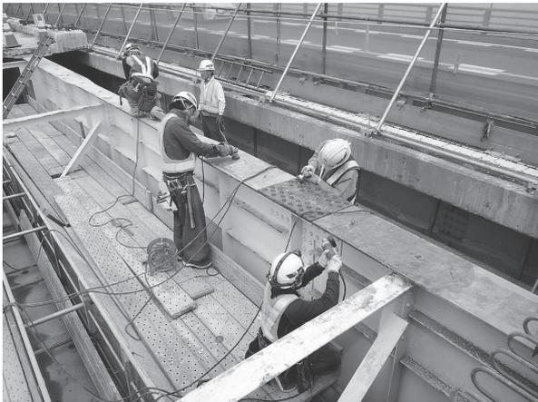
写真 - 5 主桁上フランジ清掃状況
