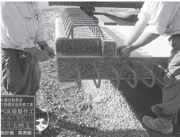
写真 - 3 打継部での鉄筋配置
