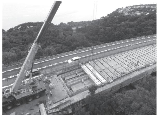
写真 - 7 PCaPC床版架設状況
