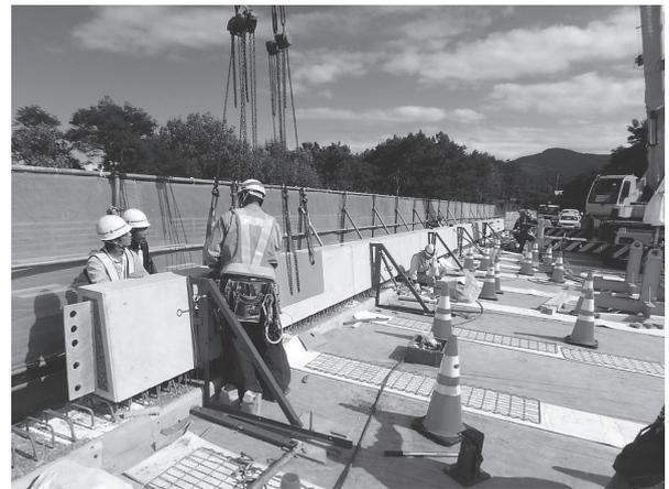
写真 - 9 DAK 式壁高欄プレキャスト部材設置状況
