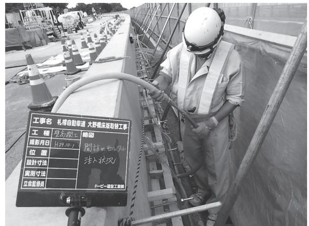
写真 - 10 壁高欄間詰めモルタル注入状況
