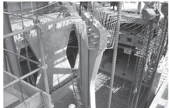
写真-5 パネルの設置状況
