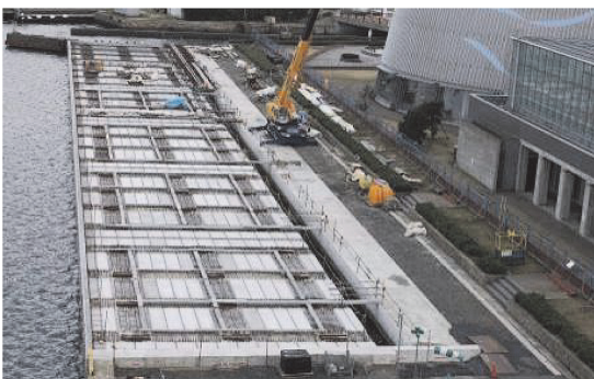
写真 - 5 PC 板架設完了状況
