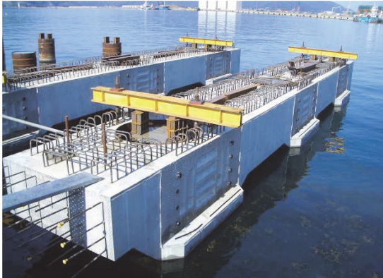
写真 - 3 PC 主梁架設完了状況
