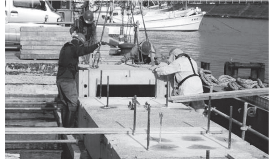
写真 - 11 法線平行方向床版架設状況
