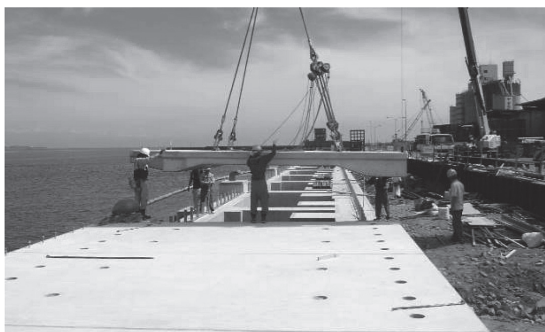
写真 - 9 PC床版架設状況
