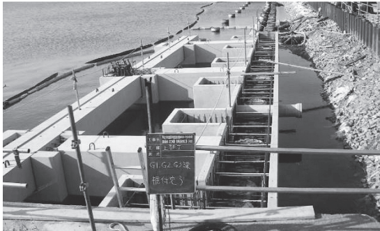
写真 - 8 骨組部材架設完了状況
