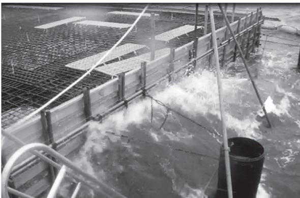
写真 - 1 場所打ち RC 栈橋施工状況 (例)
