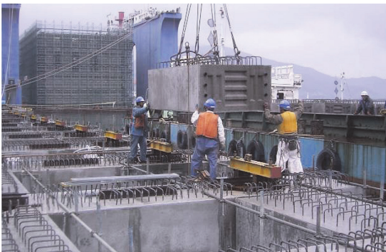
写真 - 4 横梁架設状況
