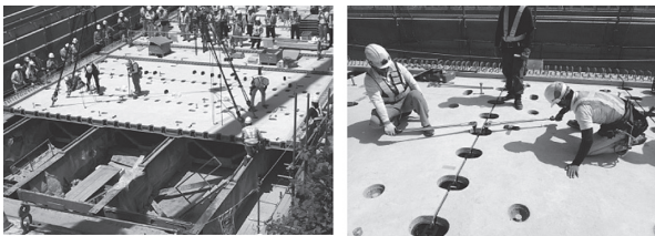
(a) 架設状況 (b) トルク導入状況 写真 - 13 コッター継手床版施工状況
