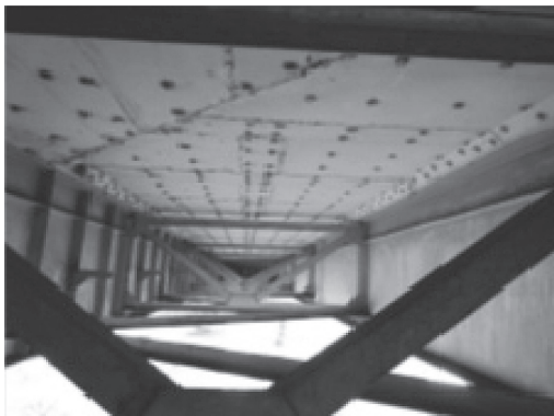
写真 - 6 床版下面 鋼板接着補強事例
