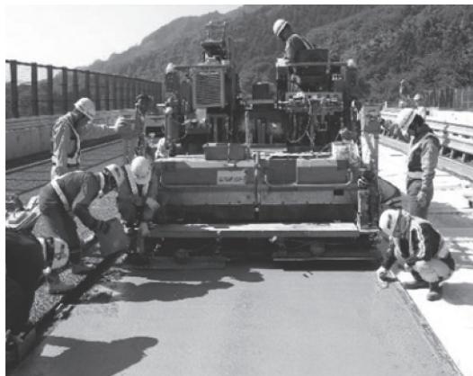
写真 - 5 床版上面増圧施工状況
