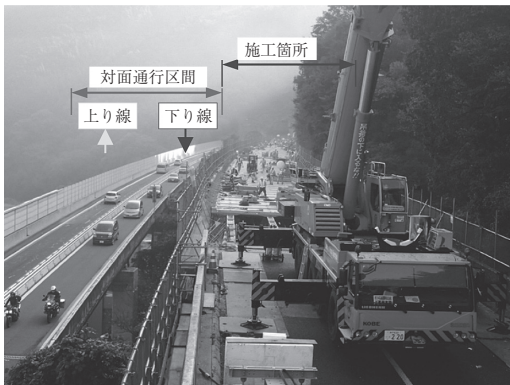
写真 - 10 工事状況事例 2)
