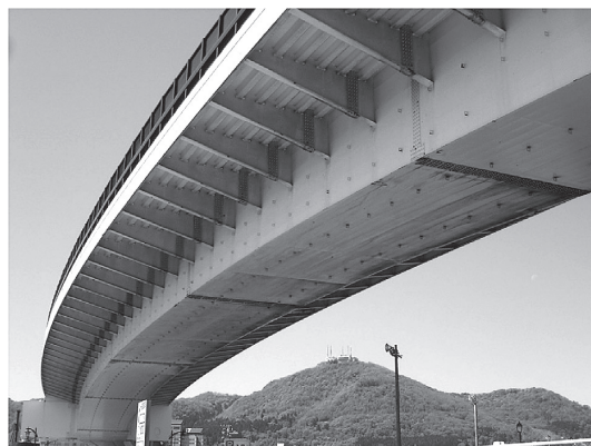
写真 - 10 ともえ大橋の鋼床版
