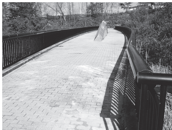
写真 - 19 望景橋の橋面とフィンバック
