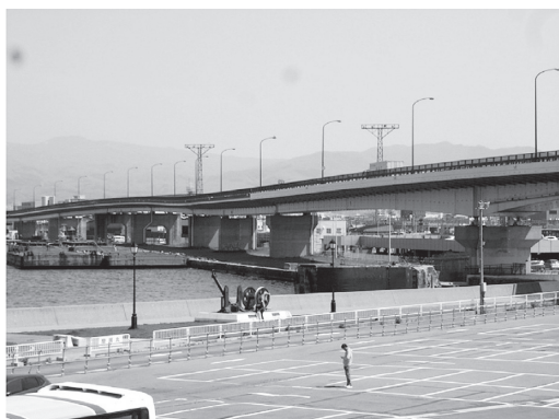
写真 - 8 ともえ大橋（青函連絡船記念館の摩周丸から）
