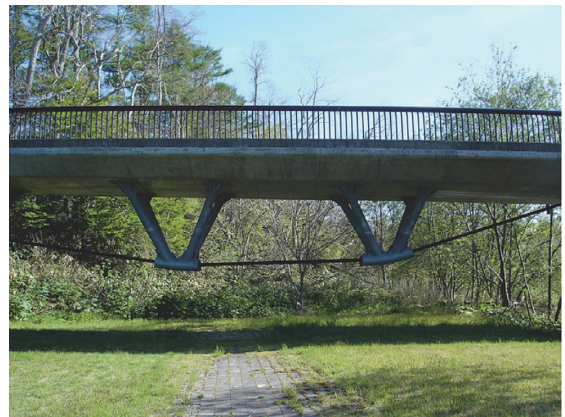
写真-17 望景橋のストラットと偏向部
