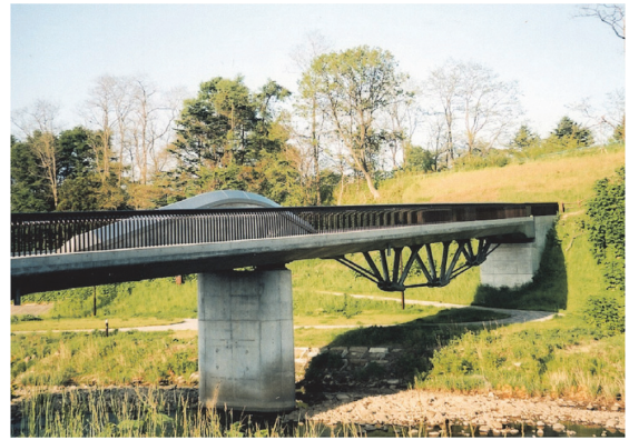
写真-15 望景橋のフィンバック
