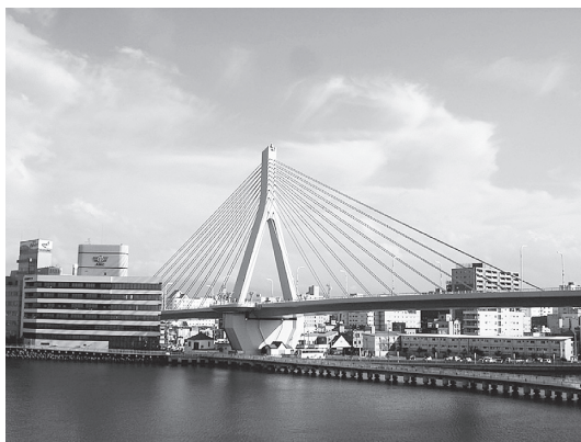
写真-3 黄金に輝くファン形斜材と主塔
