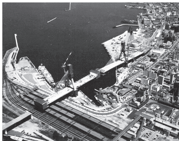
写真-1 架設中の青森ベイブリッジ (JR東日本よりご提供)
