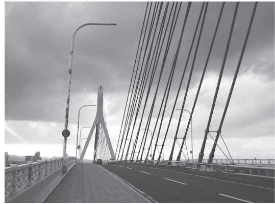
写真-5 主塔と広幅員（25m）の橋面
