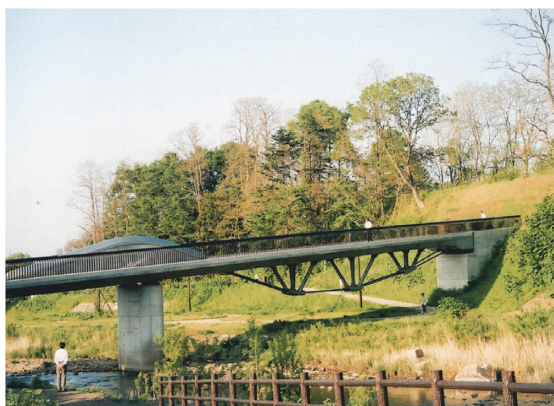
写真-14 竣工直後の望景橋
