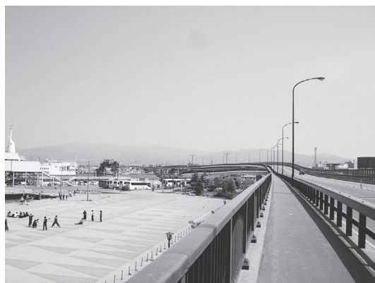
写真 - 11 ともえ大橋の歩行者用通路
