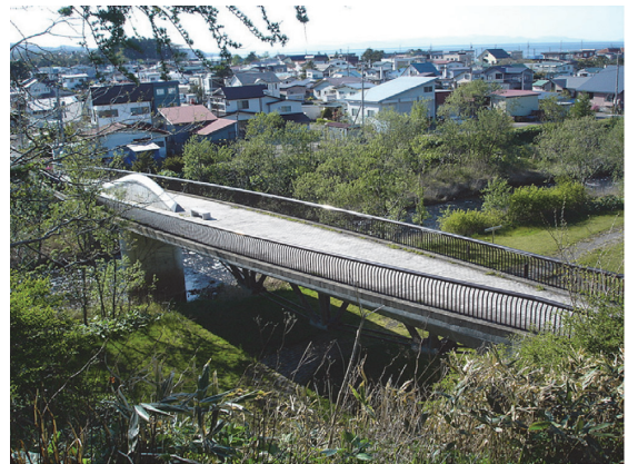
写真-16 望景橋の全景
