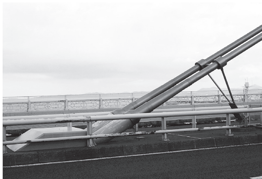
写真-4 一面吊りのPC斜材のFRP管
