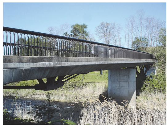
写真-18 望景橋の偏向部
