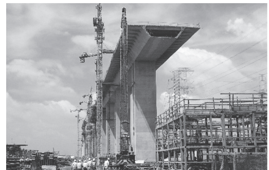
写真 - 11 アプローチ部PC箱桁橋の施工状況
