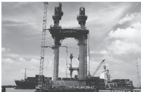
写真 - 8 主塔の施工状況
