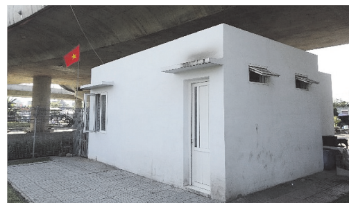
写真 - 7 橋梁下に設置されたモニタリング室
