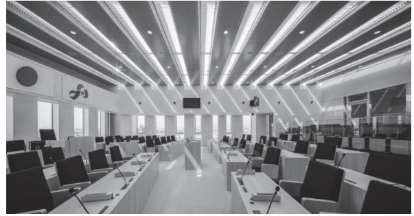
写真 - 4 SU 版を用いた天井
