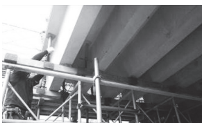
写真 - 20 ST 版設置状況
