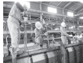
写真 - 9 PCa 打設状況
