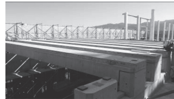
写真 - 22 SU 版設置・躯体接合状況
