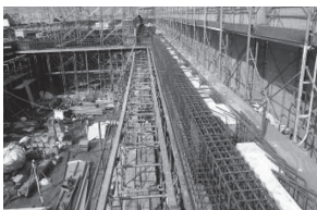
写真 - 18 ST 版架設前
