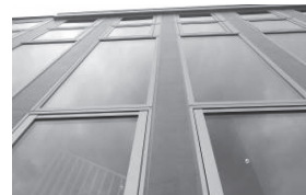
写真 - 23 PCa 柱外観
