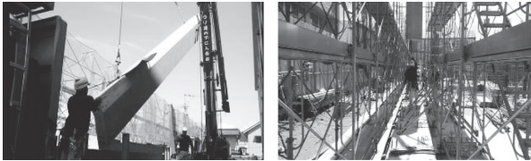
写真 - 15 PCa 柱建て起こし 写真 - 16 PCa 柱架設状況
