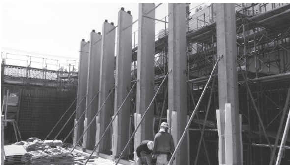
写真 - 17 PCa 柱設置状況
