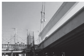
写真 - 19 ST 版架設状況
