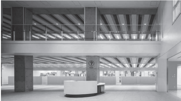
写真 - 3 ST 版を用いた天井
