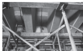
写真 - 21 ST 版面戸部の型枠
