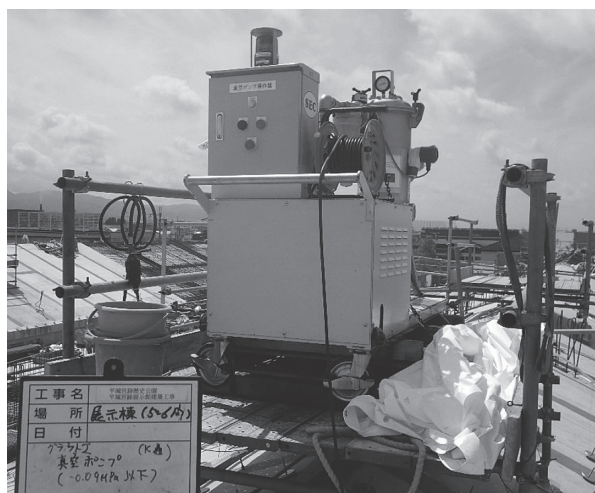
写真 - 3 グラウト工事 真空ポンプ使用状況
