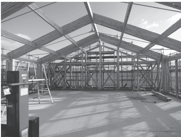
写真 - 4 施工写真 (復原事業情報館・代表軸組部)
