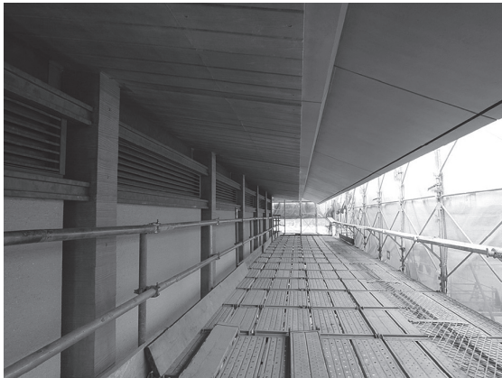
写真 - 1 軒天（コンクリート打設後）
