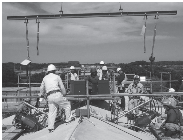
写真 - 2 山形ラーメン架構・頂部同時緊張の様子
