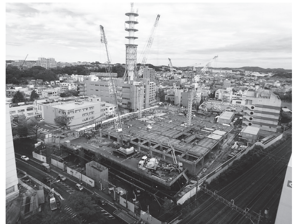
写真 - 3 建方状況
