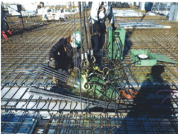
写真 - 9 PC大梁緊張状況
