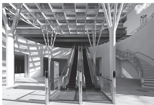
写真-2 サークルプラザからの入口
