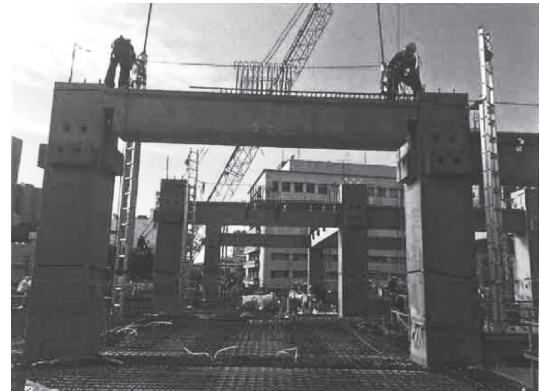
写真-7 大梁架設状況
