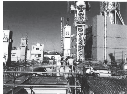
写真-6 柱架設状況
