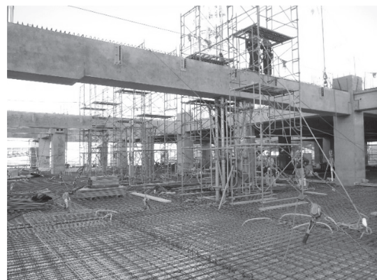
写真-8 18mスパン大梁架設状況
