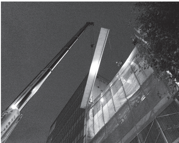
写真 - 10 外装水平ルーバー揚重状況
