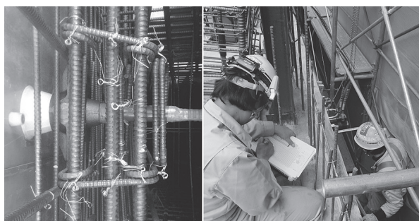
写真 - 4 PC 鋼材梁端部納まり (左) と緊張時状況 (右)
