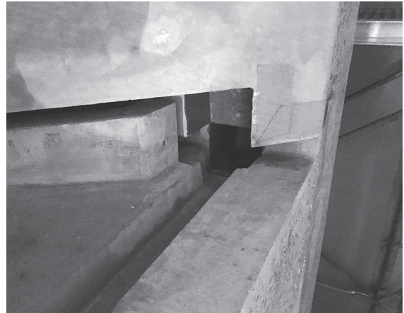
写真 - 13 外装水平ルーバーと袖壁取合
