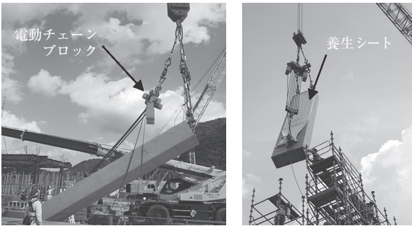
建て起し 吊姿 写真 - 10 斜め柱の建方状況
