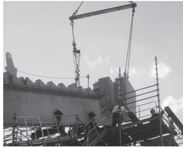
⑤ 接合部架設
