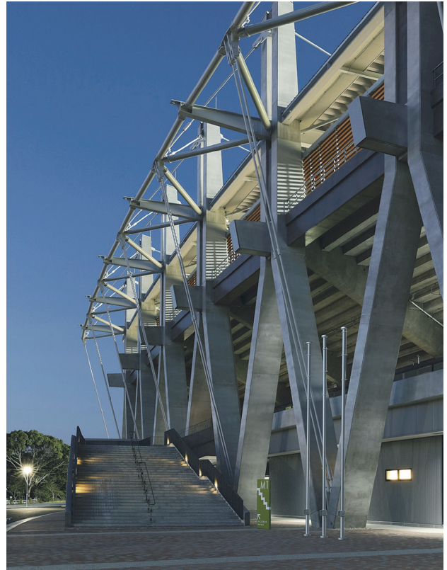
写真 - 6* 外観 南西面
