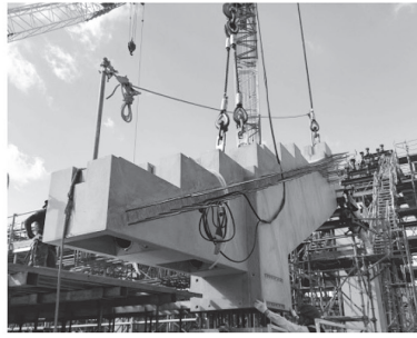
② 下段段梁架設
