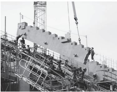
④ 上段段梁架設
