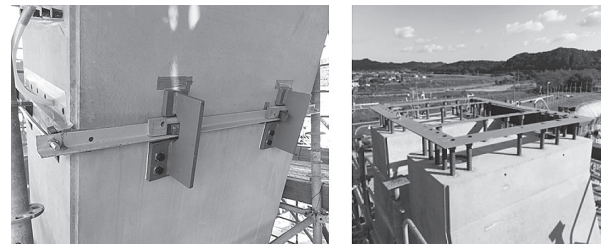
ずれ止め金物 テンプレート 写真 - 11 斜め柱の仮設状況
