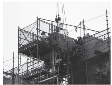
⑥ 片持ち梁架設
