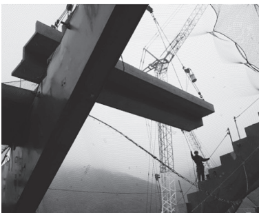
⑩ 段床架設
