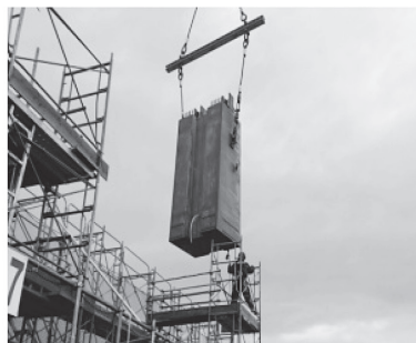
⑪ 片持ち柱建方
