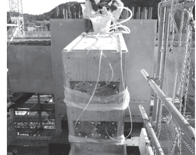
⑨ PC グラウト注入
