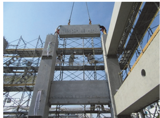
(c) 桁行方向 PCa 梁架設状況
