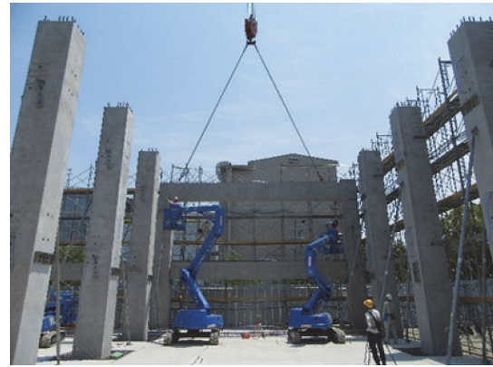
(b) 梁間方向 PCa 梁架設状況
