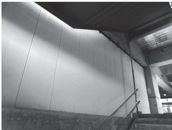
写真 - 3 防火区画壁（ALC パネル）と鉄骨階段
