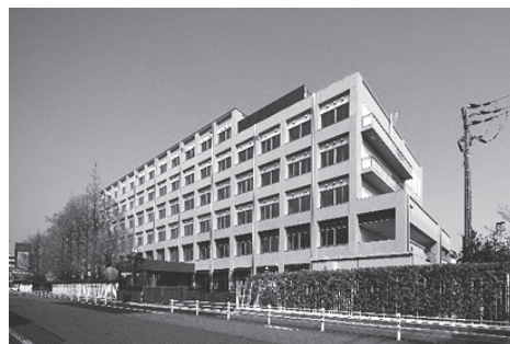
写真-1 新校舎の外観
