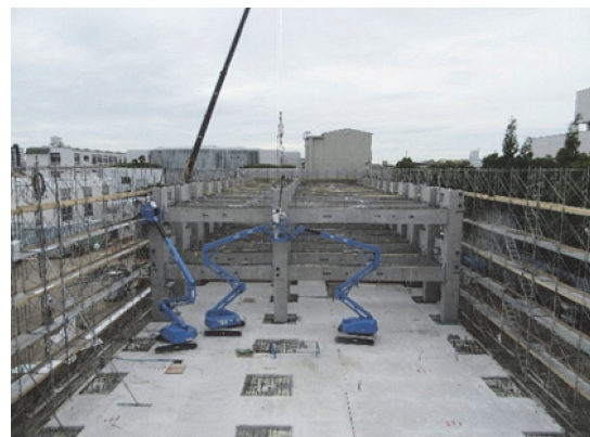
(d) 1 節目 2・3 工区架設完了状況
