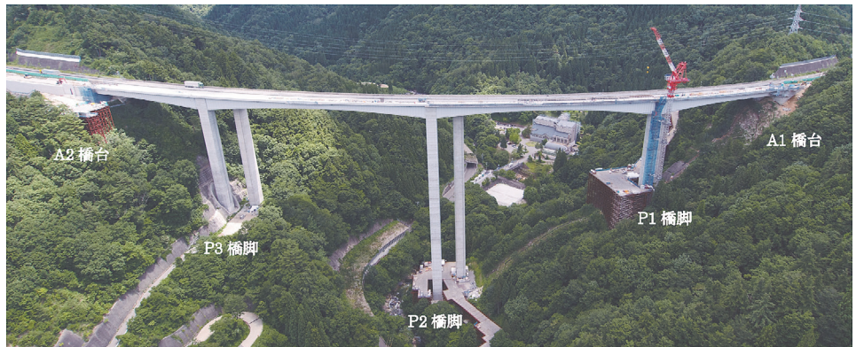
写真-10 全景写真（平成30年7月撮影）
