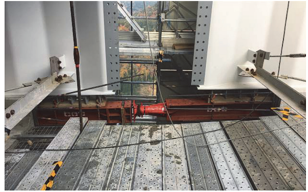
写真-8 閉合部施工状況（水平ジャッキ）
