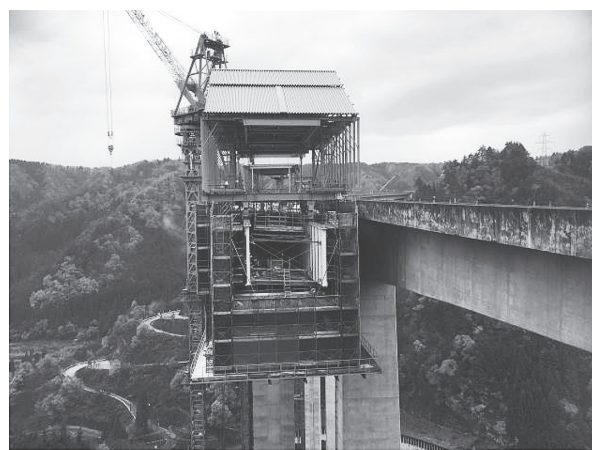
写真 - 7 P1架設作業車
