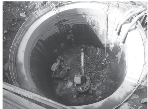
写真 - 3 大口径深礎施工状況
