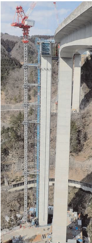
写真-9 P2橋脚完成全景
