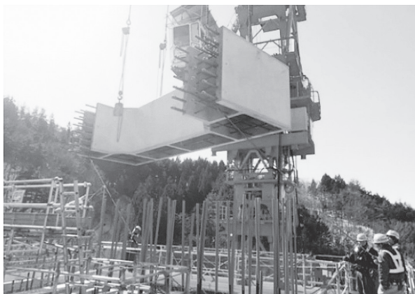
写真 - 4 プレキャスト部材架設状況
