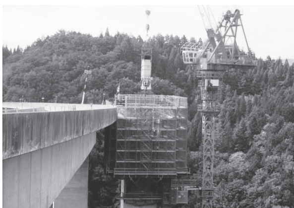
写真 - 6 柱頭部施工状況
