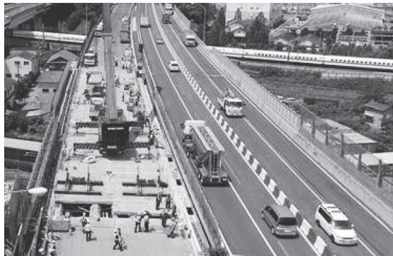
写真 - 4 樹脂製防護柵による対面通行規制
