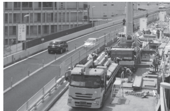
写真 - 3 ポストコーンによる対面通行規制
