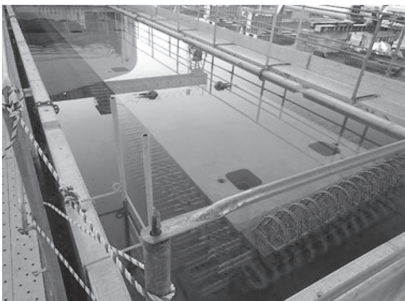
写真 - 1 プレキャスト PC 床版の水中養生状況
