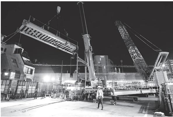
写真 - 5 工事桁撤去
