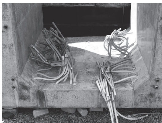
(a) 補修あり (漏水なし)
