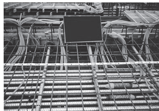
写真 - 5 平成初期頃の張出し架設橋ホース配置状況
