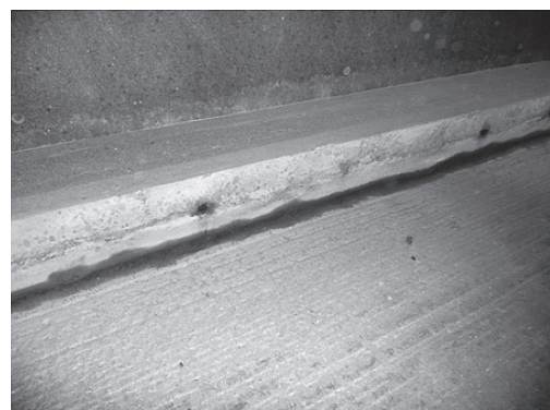
写真 - 10 緑石撤去後の地覆側面の状況
