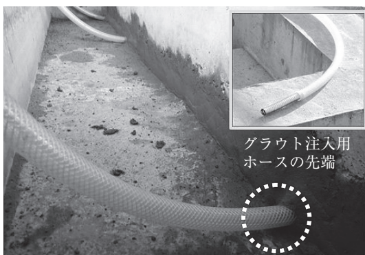
写真 - 14 ポリマーセメントモルタルによる修復
