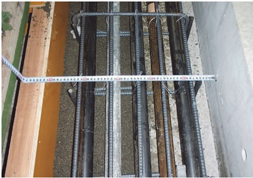
写真 - 12 模擬地覆内の配筋・鋼管設置
