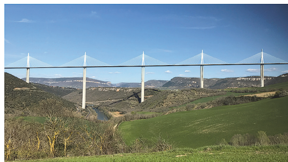
写真 - 3 ミヨー高架橋
