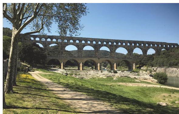
写真 - 4 Pont du Gard
