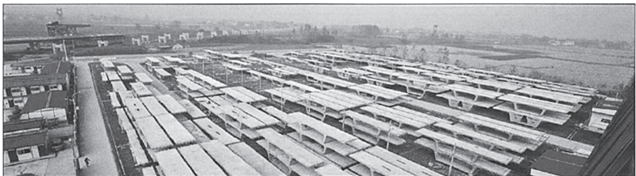
図 - 1 プレキャスト仮置き状況
