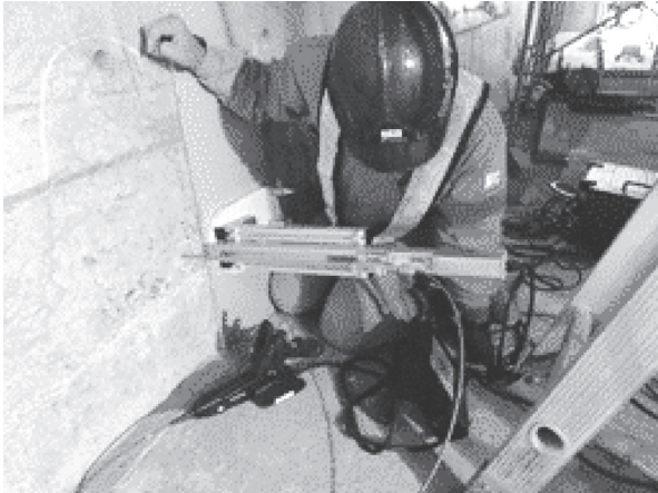
写真 - 2 CCDカメラによる内部調査
