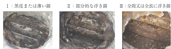
図 - 4 腐食度判定基準
