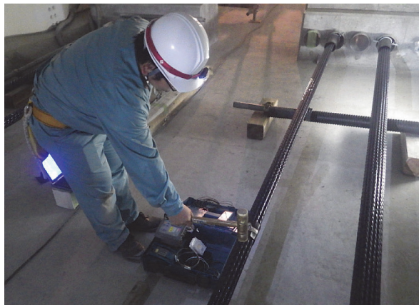
写真 - 3 高次振動法による張力測定
