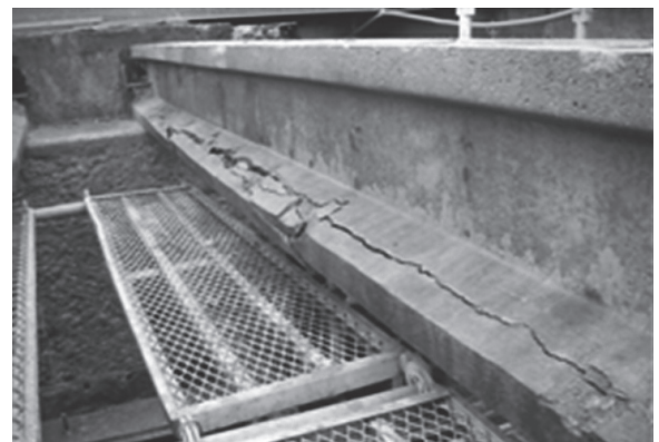
(b) 山側の桁 (D 桁) の支承付近
