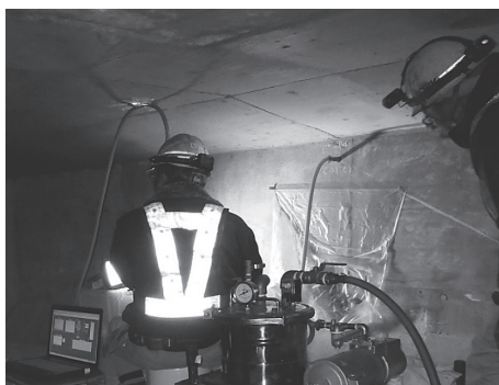
写真 - 6 施工状況
