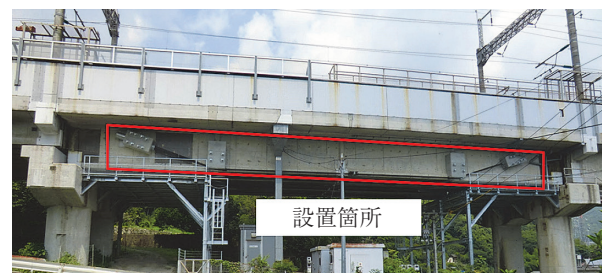
写真 - 2 設置状況
