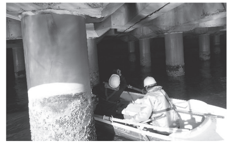
(c) 一般的な点検状況 (目視点検)
