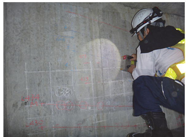
写真-3 箱桁橋ウェブの着磁状況
