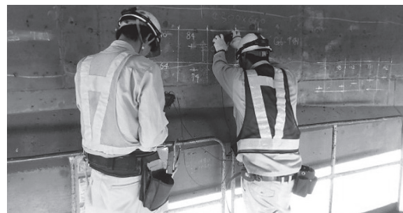
写真-12 ドライ超音波測定状況
