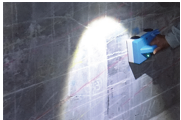
写真-4 箱桁橋ウェブの磁束密度計測状況
