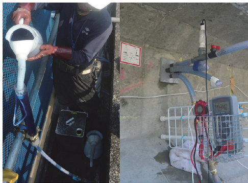
(上：亜硝酸リチウム水溶液の注入状況)
