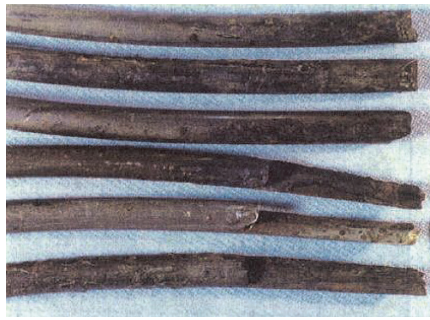
写真 - 1 PC 鋼線の破断事例 1)
