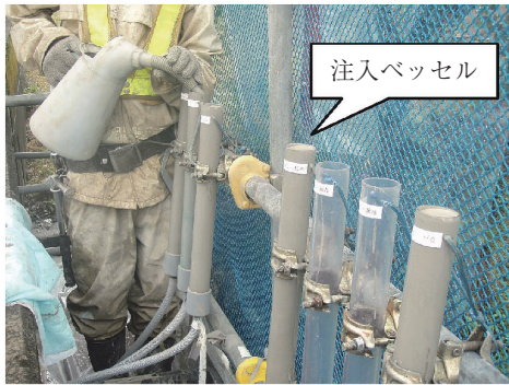
(上：亜硝酸リチウム水溶液の注入状況)
