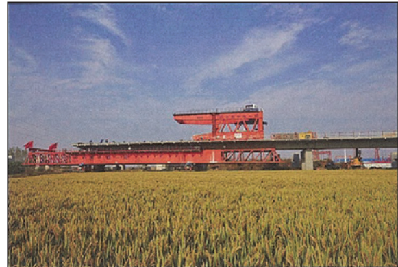
図 - 12 セグメント架設状況（下路式架設機）
