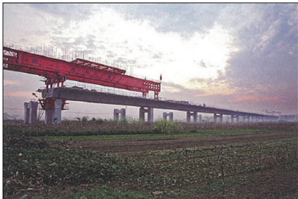
図 - 11 セグメント架設状況（上路式架設機）
