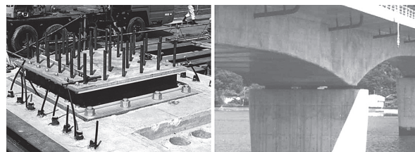
橋脚天端設置 場所打ち桁架設 写真-6 免震支承の設置例
