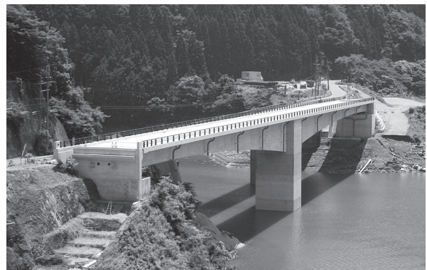
写真 - 2 工事完了全景
