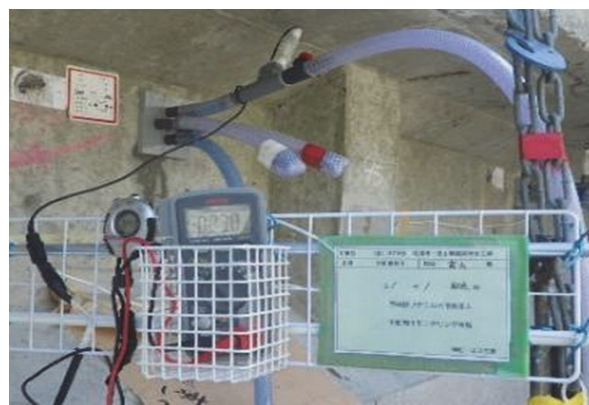
写真 - 5 PC鋼材の自然電位の計測例
