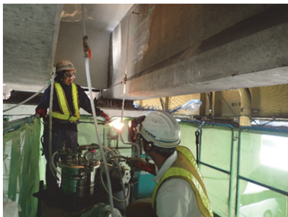
写真 - 3 PCグラウト再注入作業状況の例
