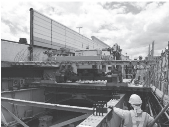
写真 - 5 専用架設機を用いた UFC 床版の設置状況
