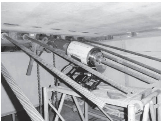
写真 - 6 交差定着部の緊張状況
