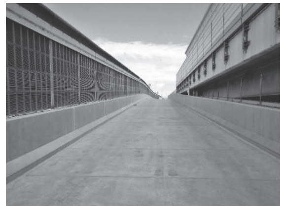
写真 - 7 UFC 床版施工完了
