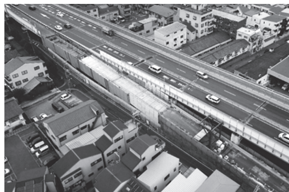
写真 - 1 玉出入路橋
