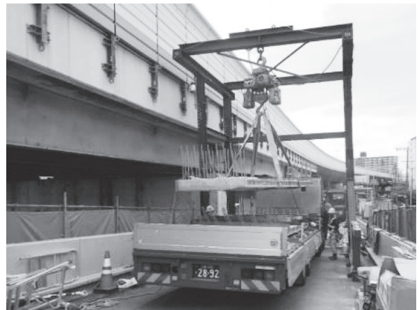
写真 - 4 UFC 床版の搬入状況
