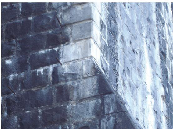
写真 - 5 アーチダムのバットレスの鉛直部と斜面の隅部に設置されているコンクリートブロック
