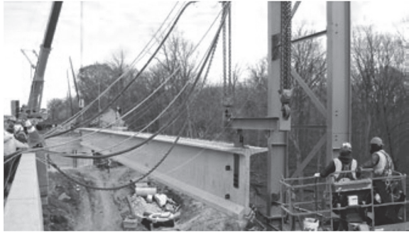
写真 - 2 主桁架設状況
