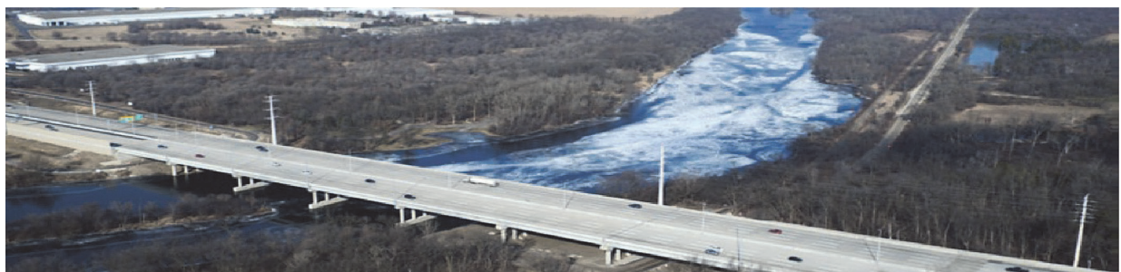
写真 - 1 工事完了状況
