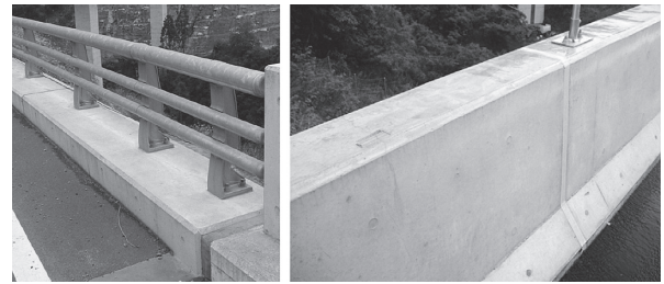
橋梁用ビーム型防護柵 コンクリート製防護柵（壁高欄）
