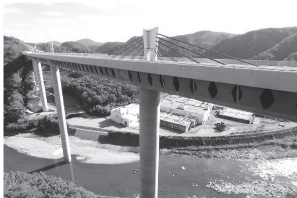
写真 - 8 新名神武庫川橋
