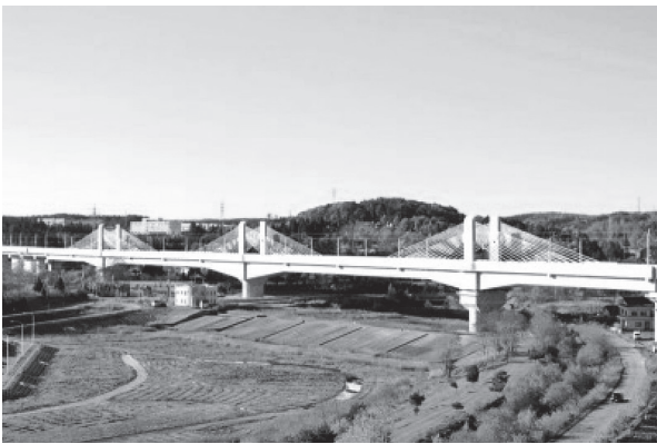
写真 - 13 三内丸山架道橋
