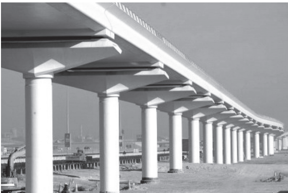
写真 - 3 ドバイメトロ高架橋
