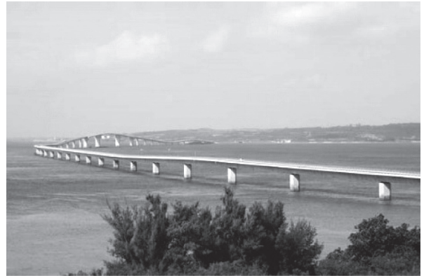
写真 - 4 伊良部大橋
