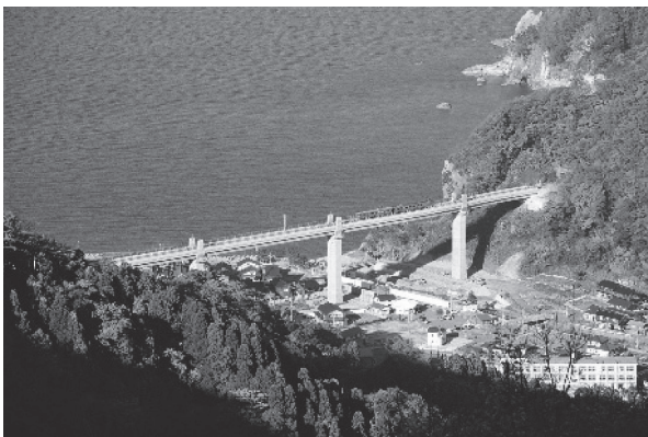
写真 - 14 余部橋梁
