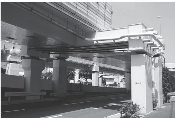
写真 - 17 首都高速1号羽田線 勝島地区橋梁
