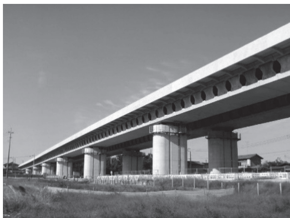
写真 - 7 桶川高架橋
