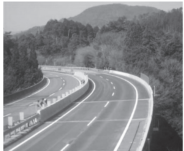
写真 - 18 床版取換え （中国自動車道 道谷第二橋（上り線））
