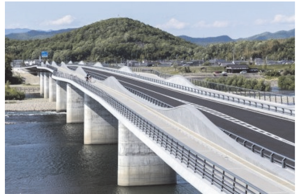
写真 - 11 各務原大橋
