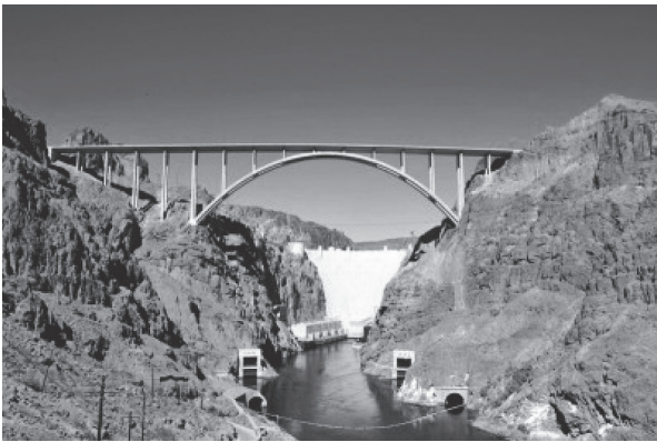
写真 - 2 コロラドリバー橋
