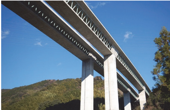
写真 - 9 猿田川橋・巴川橋
