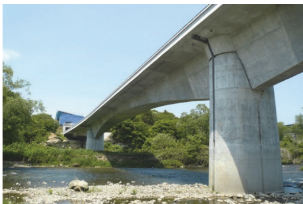
写真 - 10 広瀬川橋梁
