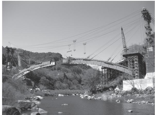
写真 - 9 アーチ（メラン材）架設状況
