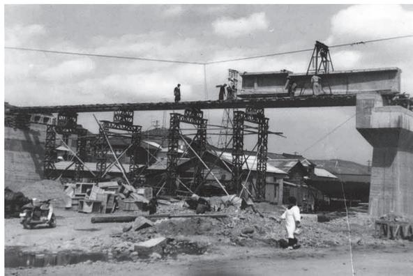
写真 - 1 ポステン桁の架設
