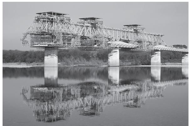
写真 - 7 P&Z 工法による架設
