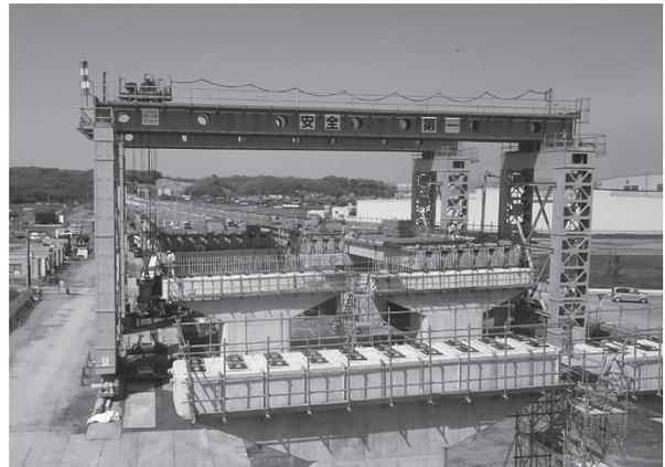
写真 - 3 大型門型クレーン架設
