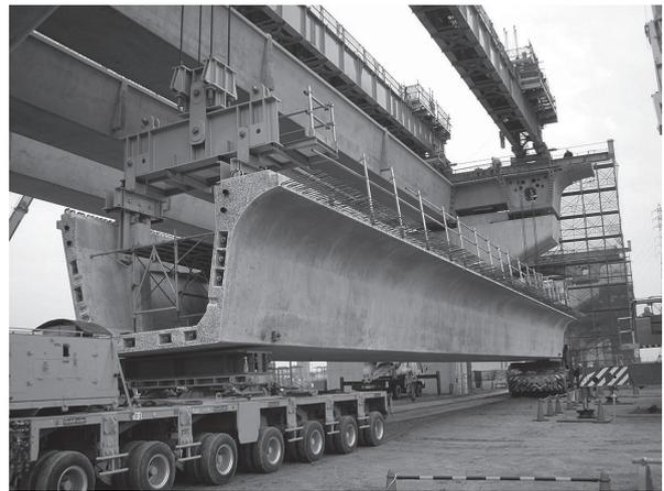
写真 - 2 U 型コンポ橋の架設
