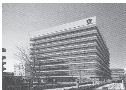
写真 - 13 藤沢市新庁舎
