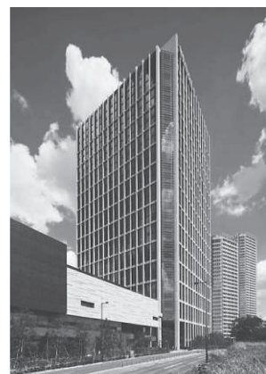
写真-6 二子玉川ライズII-a街区高層棟
