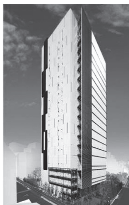
写真-5 東京第5データセンター
