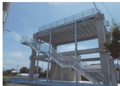
写真 - 11 掛川市今沢地区津波避難タワー
