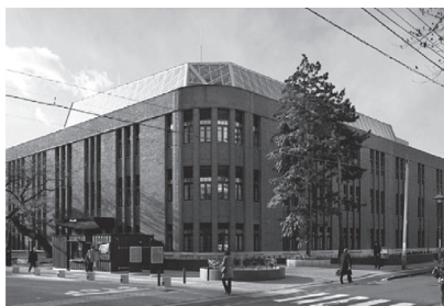
写真-2 東北大学インテグレーション教育研究棟
