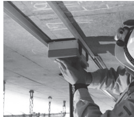
写真 - 7 漏洩磁束法によるPC鋼材破断調査状況
