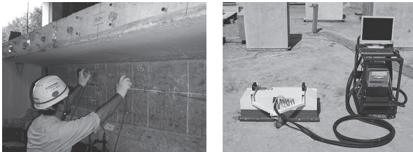
(a) 広帯域超音波法 (b) マルチパスアレイレーダ法 写真 - 6 非破壊検査によるPCグラウト充填検査
