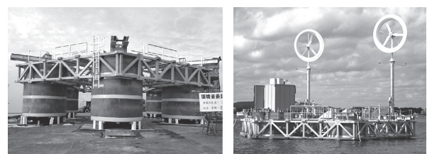
写真-1 PC技術を用いた洋上風力浮体
