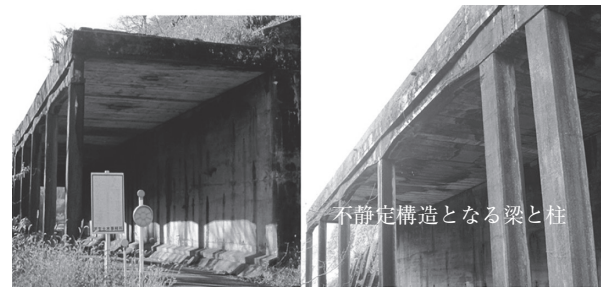
写真 - 5 現存する山中ロックシェッド (筆者撮影)
