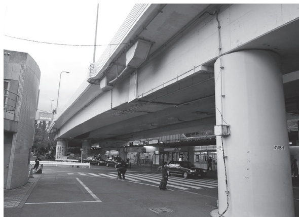
写真-2 高速4号千駄ヶ谷駅付近(施工前)
