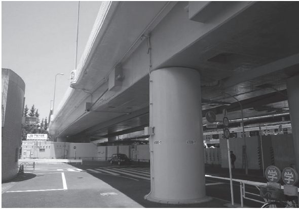
写真 - 7 高速 4 号千駄ヶ谷駅付近 (施工後)
