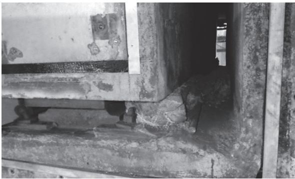
写真 - 3 ゲルバー遊間清掃完了状況
