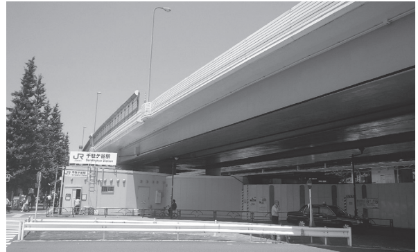
写真 - 9 完成状況
