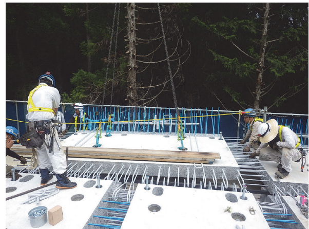
写真 - 1 張出し床版架設状況
