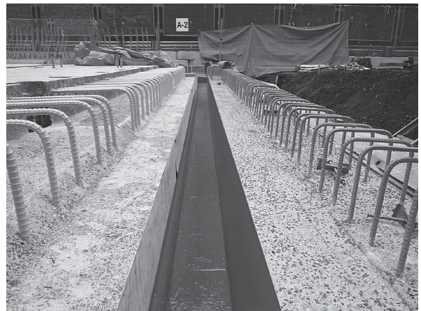
写真 - 4 セットバックジョイント排水溝
