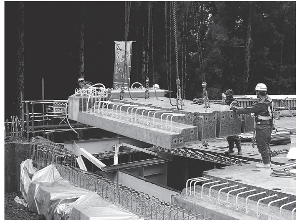
写真 - 3 A2 端部版の架設状況
