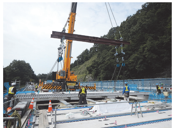
写真 - 2 PCaPC床版の架設状況
