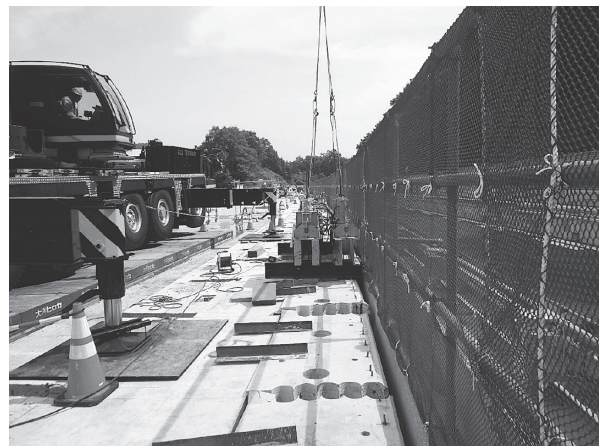
写真 - 5 張出し床版撤去状況
