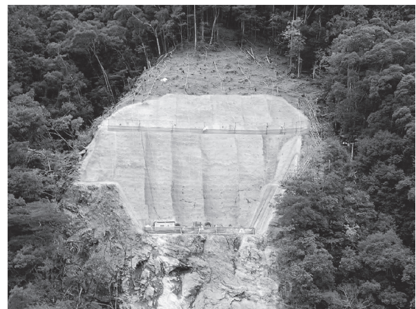
写真 - 7 A1 橋台法面工完了状況
