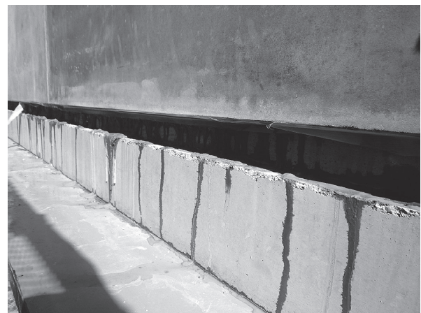
写真 - 9 実物大模型の打設後接続部状況
