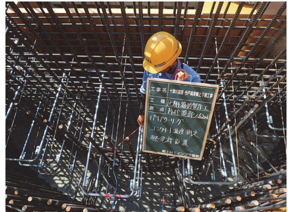
写真 - 3 熱電対設置状況
