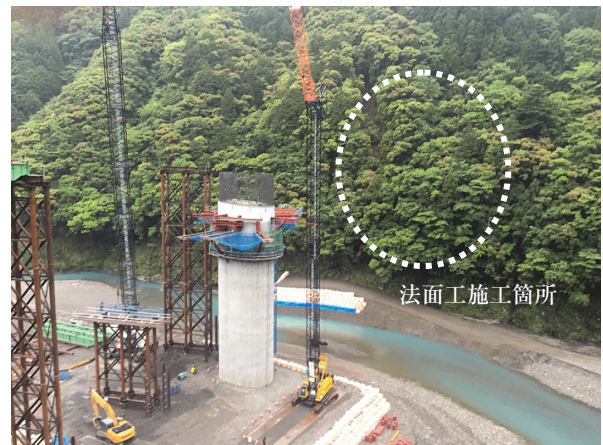
写真 - 4 法面工開始前状況
