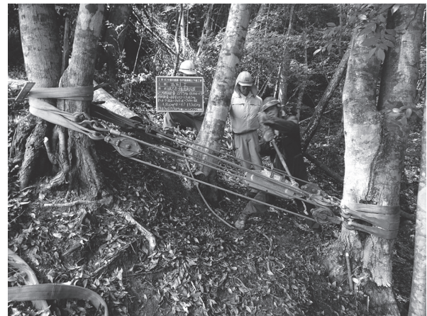
写真 - 5 立木アンカー引張強度試験状況
