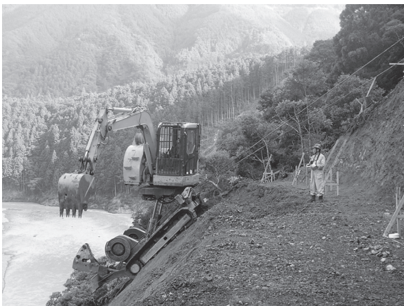
写真 - 6 遠隔操作による掘削状況
