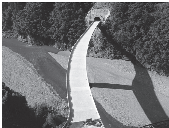
写真 - 11 完成状況(平成31年1月撮影)
