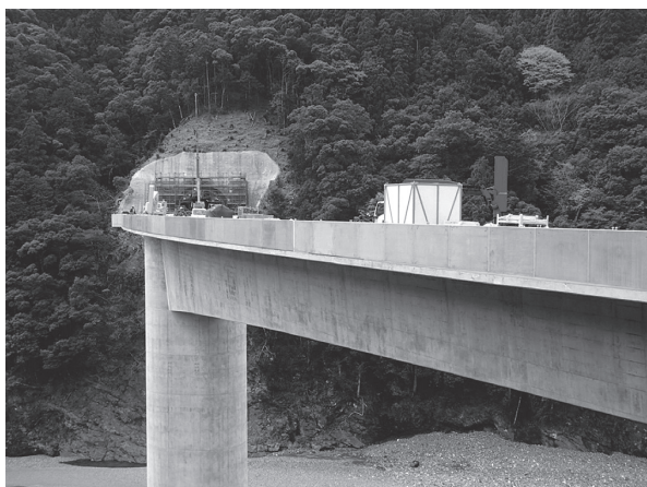
写真 - 10 壁高欄施工完了後状況
