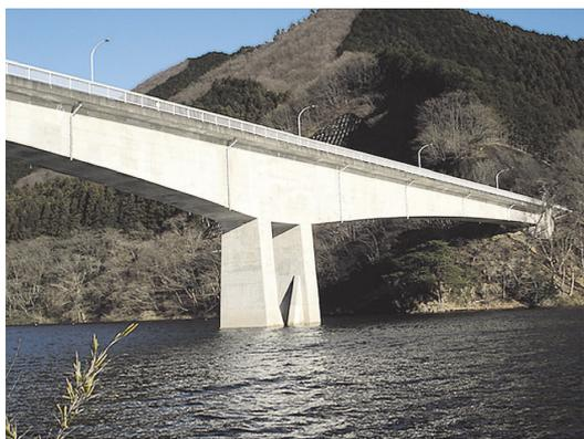
写真 - 9 梅田大橋の2枚壁橋脚
