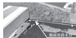
図-4 橋面用排水設備例 2)
