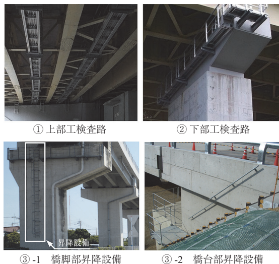
写真-3 検査路の設置事例
