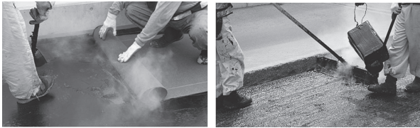
① シート系防水層の施工事例 ② 塗膜系防水層の施工事例 写真 - 1 防水層の施工事例
